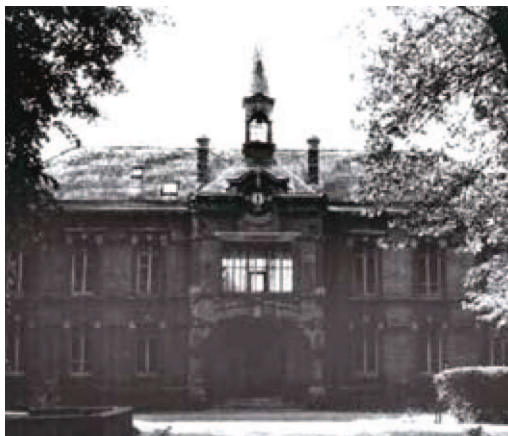
△ Warmeriville. Bâtiment principal de la filature Harmel.
